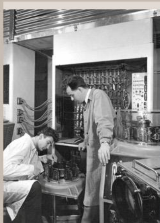
A mágnesdob szerelése közben az MTA Kibernetikai Kutatócsoportjánál.
